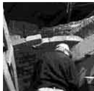
図2 アーチ式丸天井を、型枠を用いずフリーハンドで造っている。サン・アントニウス教会堂、ドイツ、デュッセルドルフ'02.4 撮影 五島/T.Shumacher (科研費による調査)
